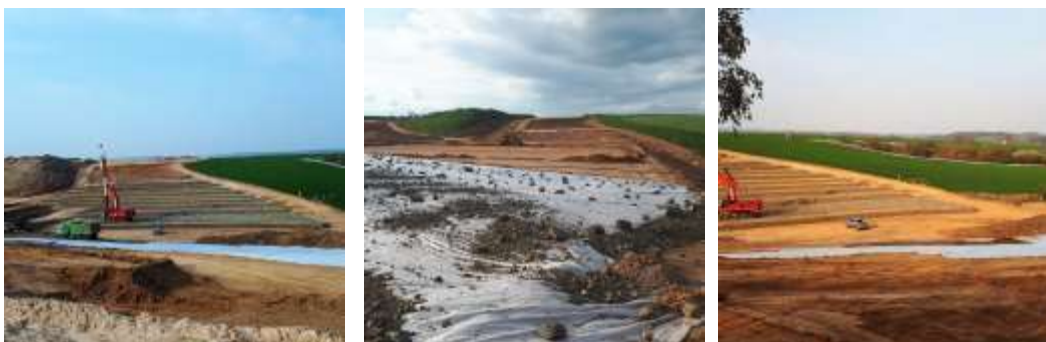
Výstavba dálnice D11
