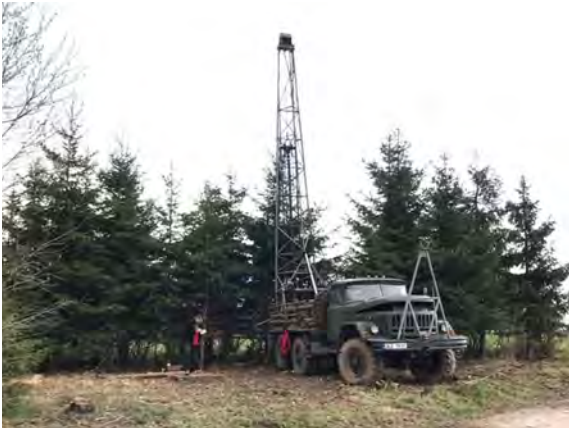
Jádrové vrtý pro pilotáž nadzemního vodojemu a anténní věže na Hřibojedském – Libotovském vrchu
